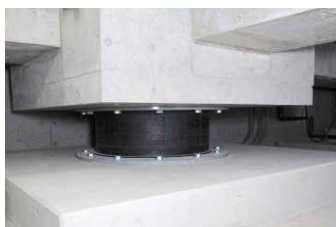
震度7を5弱程度に軽減する 免震積層ゴム
