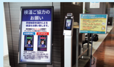
非接触型体温計（データセンター入口）
