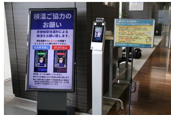
非接触型体温測定機設置(データセンター入口)
